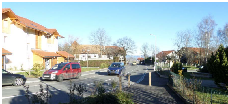
Enjeu de l'insertion dans le contexte actuel de centre-bourg (lecture des formes urbaines à l'alignement sur rue), équipé et sécurisé
